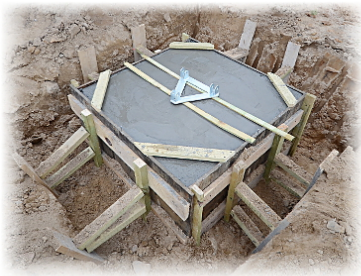
Gotowy fundament z ustawionym masztem:
