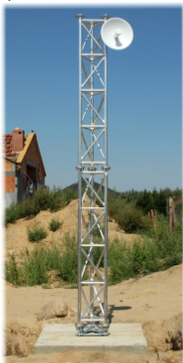
Przygotowany szalunek pod fundament masztu:
