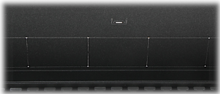
Holes for fan coolers
